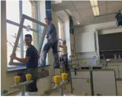
Am 26.04.2018 wurde der Baubeschluss zur Fenstererneuerung am Gymnasium Alexander v. Humboldt, Haus I, gefasst. Diese ist notwendig, da die zuletzt Mitte der 90er Jahre aufgearbeiteten Fenster stark verwittert und nicht mehr reparabel sind. Weiterhin entsprechen die Fenster nicht dem heutigen Standard. Durch die Undichtigkeit waren in der Vergangenheit erhebliche Energieverluste zu verzeichnen. Die Erneuerung bzw. die Festlegung der Beschaffenheit der Fenster erfolgt in Ab-
